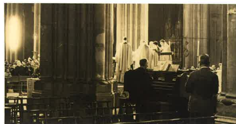
La console de l'orgue de chœur à son emplacement d'origine, 1948
