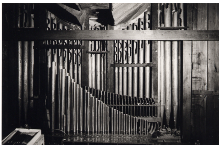
Tuyauterie du GO en cours de restauration
