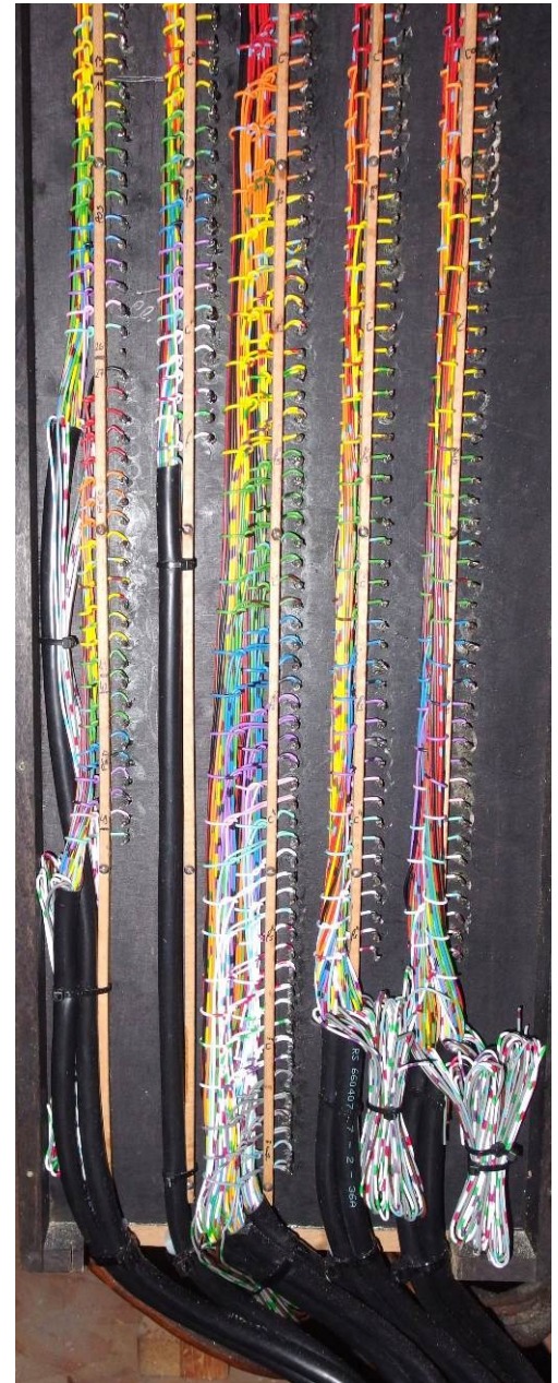
Câblage neuf (départ console)
