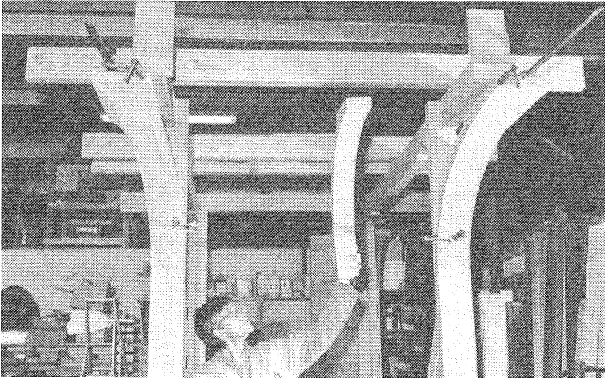
Construction du chassis du soubassement du buffet d'Arques-la-Bataille.
