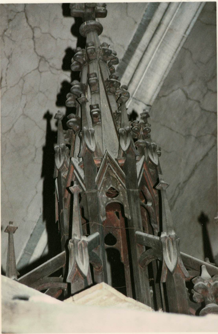
↑ BUFFET DU GRAND-ORGUE FLECHE de la TOURELLE CENTRALE (VUE de l'ARRIERE)
