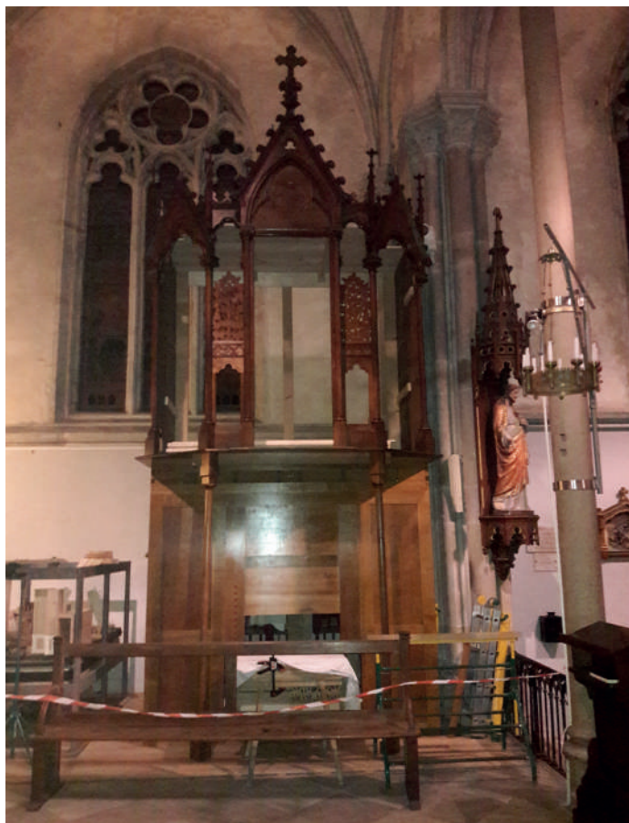
Le buffet du nouvel orgue en cours de montage, 2019
