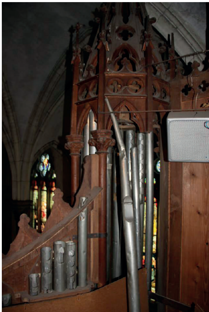
L'arrière de la façade avant restauration
