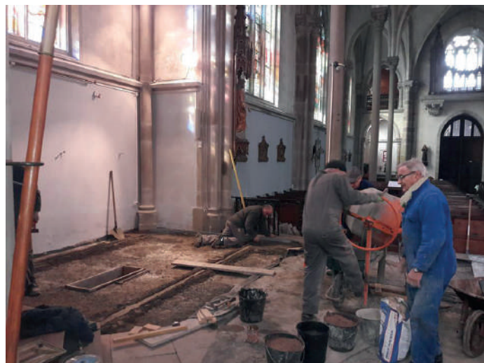
Coulage de la dalle de béton destinée à recevoir l'orgue, 2019
